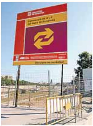
Obras de la Línea 9 en Sant Martí.
