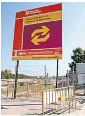
Obras de la Línea 9 en Sant Martí.
